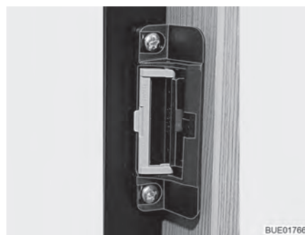
Bild 102 Verschlusseinrichtung in Lüftungsstellung
